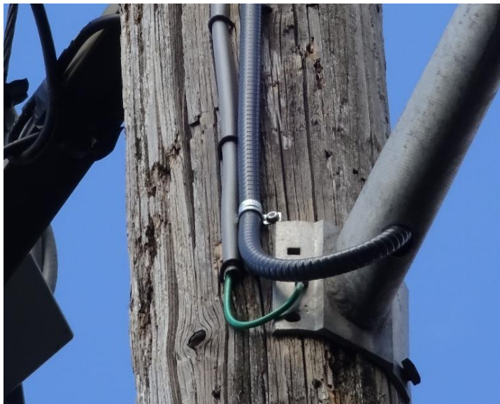
Figure 5b. Flexible Conduit
